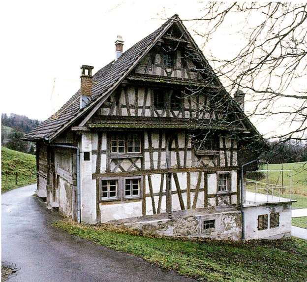
Abb. 26 Neuheim, Baarburgstrasse 10, Wohnhaus. Der in Fachwerkbauweise errichtete Hinterteil des Wohnhauses. Blick Richtung Süden.
