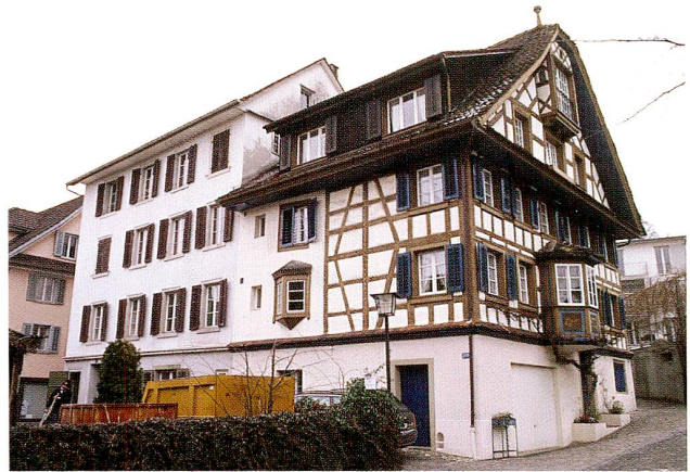
Abb. 39 Zug, Dorfstrasse 11, Wohnhaus. Westfassade des Hauses Dorfstrasse 11 (links), dessen Kernbau nicht vor 1558 erbaut wurde, und des Fachwerkhauses Dorfstrasse 9 (rechts), das vermutlich 1621 erbaut wurde. Nach dem Umbau.
