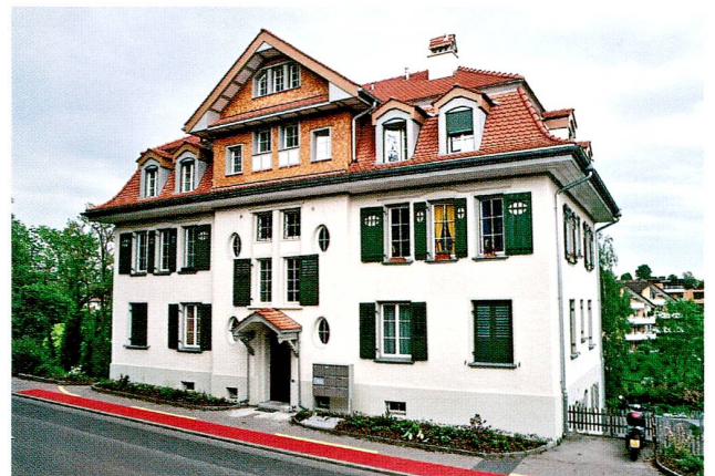
Abb. 20 Cham, Sinslerstrasse 16, Mehrfamilienhaus. Ansicht von Südwesten.
