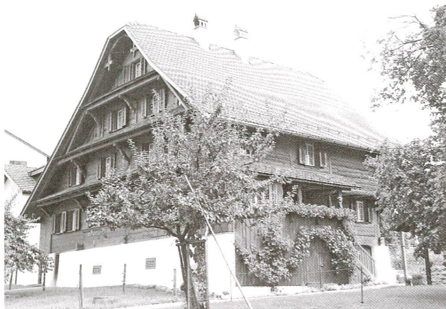
Abb. 14 Cham, Lindenham, Lindenstrasse 5, Wohnhaus. Ansicht von Osten.
