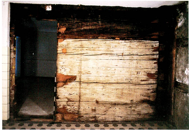
Abb. 19 Neugasse 29, zweites Obergeschoss. Ehemalige Ostfassade des Blockbaus.
