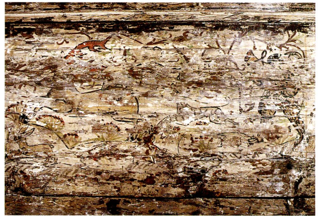
Abb. 17 Neugasse 23, zweites Obergeschoss. Nordwand der gassenseitigen Kammer. Jagdszene auf der Bohlenwand.
