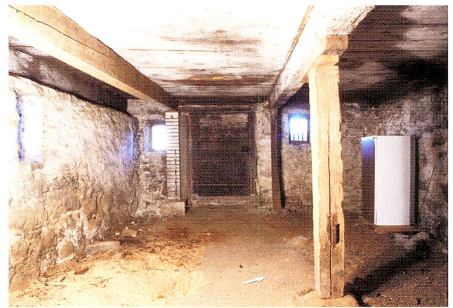
Abb. 7 Walchwil, Lauihof. Der grosse Keller (Raum 2). Blick nach Nordwesten.
