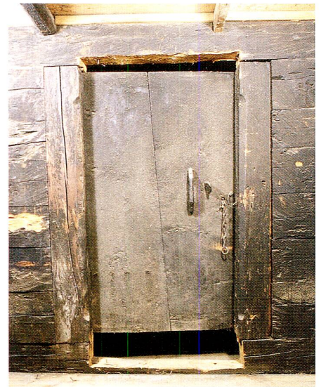
Abb. 15 Walchwil, Lauihof. Aussenseite der Türe in die Kammer über dem Südteil der Küche (Raum 16) im Obergeschoss. Das Türblatt dürfte aus der Bauzeit stammen. Blick nach Nordosten.
