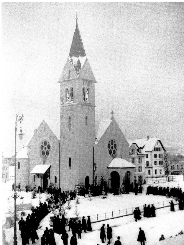
Abb. 1 Reformierte Kirche in Zug, Alpenstrasse. Einweihung am 4. Februar 1906.
