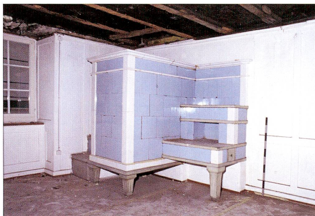
Abb. 45 Zug, Oberaltstadt 8. Der 2005 ausgebaute Kachelofen und die 2005 entfernte Bohlen-Balken-Decke im ersten Obergeschoss.
