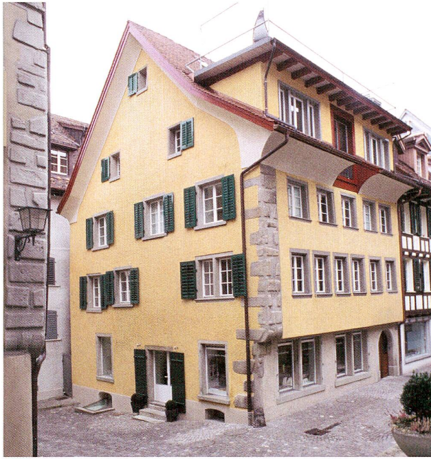
Abb. 44 Zug, Oberaltstadt 8. Das kurz nach 1522 erbaute Haus. Ansicht von Südosten.
