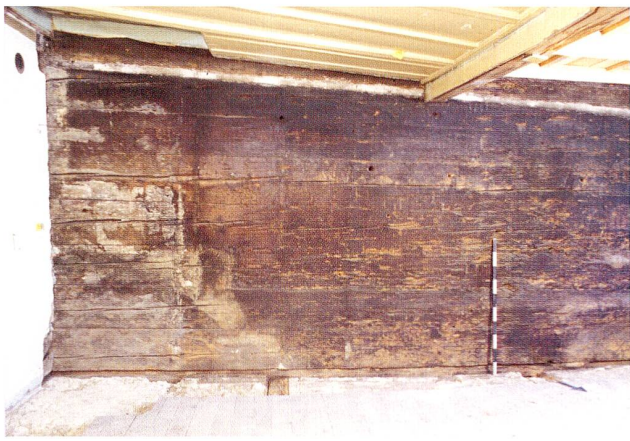
Abb. 33 Zug, Ägerstrasse 26, Restaurant Kreuz. Südwand der in Blockbautechnik errichteten Stube im ersten Obergeschoss. Links der ehemalige Standort des Kachelofens, davor der zum Teil freigelegte Mörtelstrich, oben die Nut der alten Decke.
