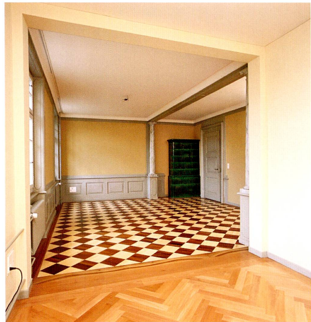
Abb. 42 Zug, Kirchenstrasse 17, Pfarrhaus St. Michael. Erstes Obergeschoss. Bischofszimmer mit zweifarbigen Würfelparkett.
