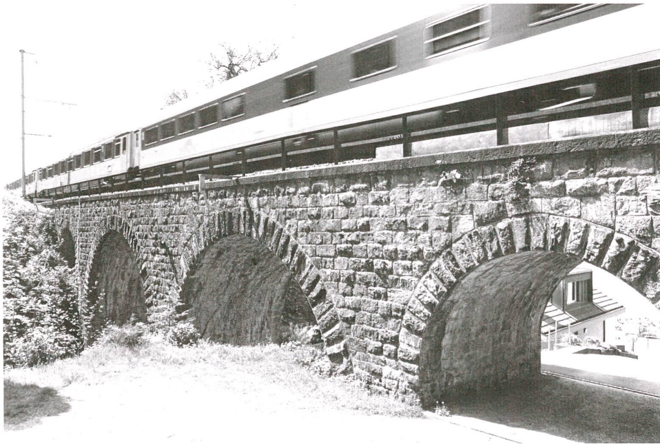
Abb. 28 Walchwil, Bahnlinie SBB, Viadukt Lotenbach. Ansicht von Nordosten.
