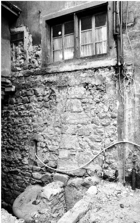
Abb. 13 Die Nordostfassade des Lughauses 1984. In Bildmitte ist die Grenze zwischen Originalbe- stand und Aufstockung vor 1371 zu erkennen, zu der die beiden Rechteckfenster gehören. Blick nach Südwesten.
