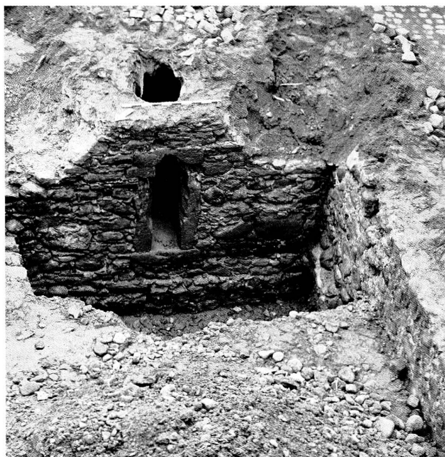
Abb. 17 Der Wehrbau (Nordwestfront) unter dem Kolinplatz mit dem Schlitzfenster in den äusseren Stadtgraben. Rechts die Zwingermauer. Aufnahme 1982.
