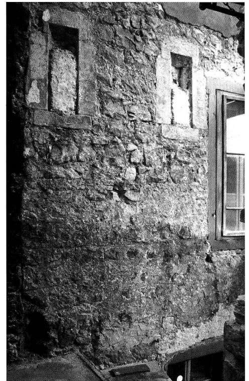
Abb. 12 Der Sockel des Lughauses (Nordostfassade) während der Bauuntersuchung 1983. Rechts der Zitturm mit Strebepfeiler, links das Lughaus mit einem der beiden Schlitzfenster. Blick nach Süden.
