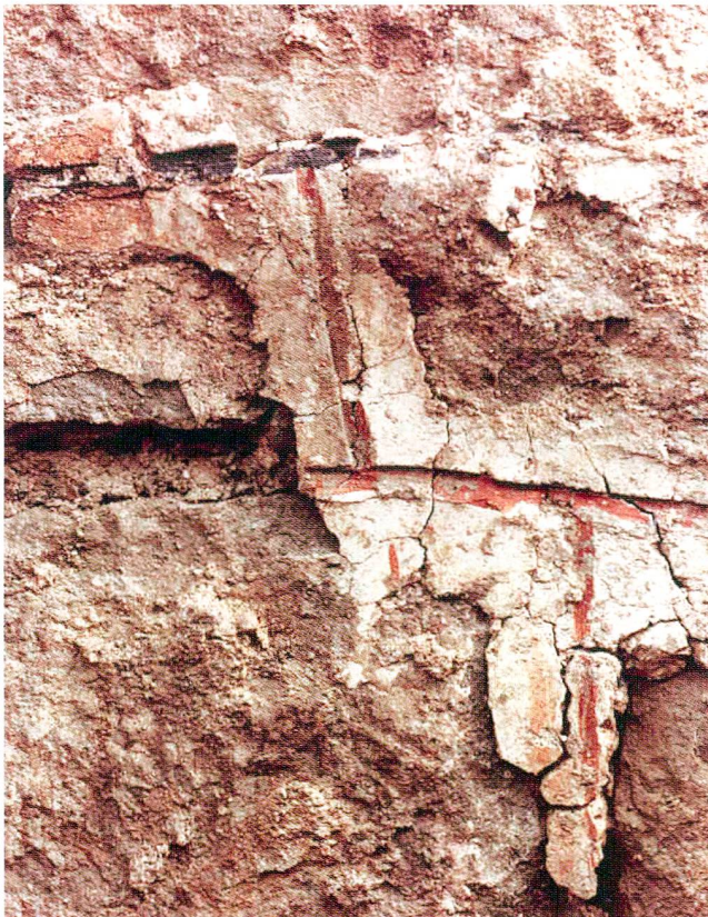
Abb. 16 Burgruine Hünenberg, Torbau, Nordmauer. Bei der Sanierung 1961/62 fanden sich Spuren roter Fugenstrichmalerei.
