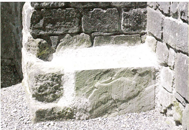
Abb. 27 Burgruine Hünenberg. Mauerecke (vgl. Abb. 31, M6/M7). 1 Vor der Restaurierung. 2 Mit reversibler Vormauerung zum Schutz originaler Sandsteinquader.
