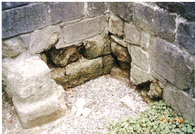
Abb. 27 Burgruine Hünenberg. Mauerecke (vgl. Abb. 31, M6/M7). 1 Vor der Restaurierung. 2 Mit reversibler Vormauerung zum Schutz originaler Sandsteinquader.
