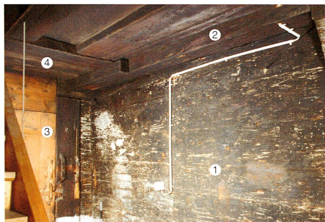
Abb. 26 Unterägeri, Unterblacki. 1 Ostwand der «Küchenkammer» im ersten Wohngeschoss. 2 Die darüber liegende Kammer ragt über die untere Kammer vor. 3 Hauseingang mit Mantelstützen aus Lärchenholz. 4 Auf eingezapften Streifbalken die quergelegten Bretter des originalen Treppenpodestes für den Aufgang ins zweite Wohngeschoss.
