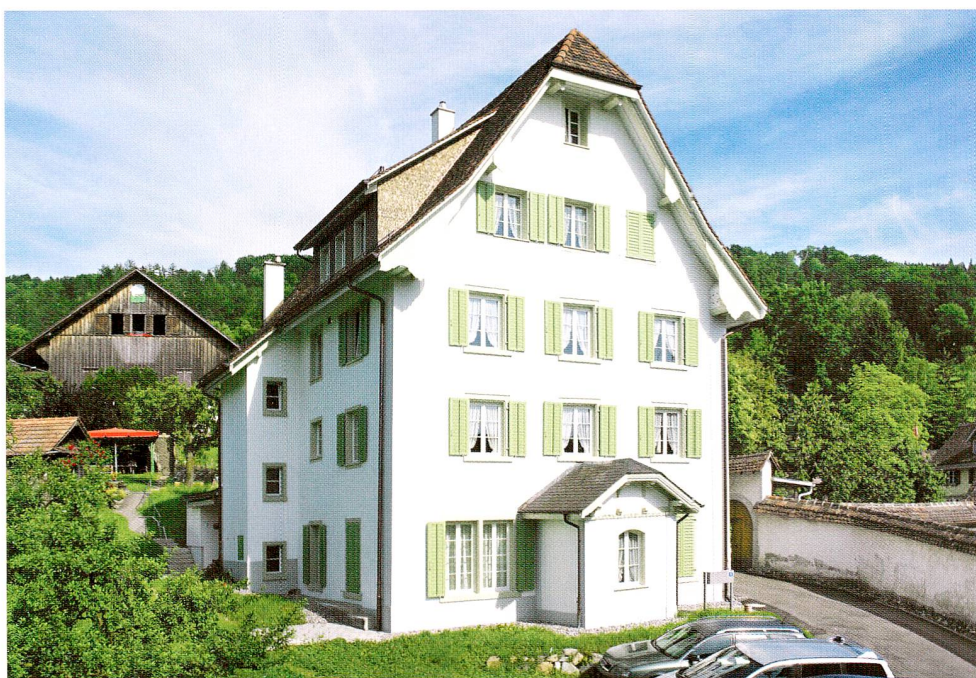
Abb. 37 Zug, Klosterstrasse 6, Pächterhaus. Ansicht von Westen.
