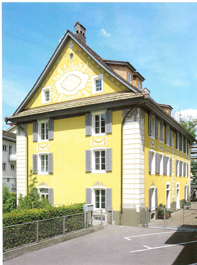
Abb. 6 Baar, Zugerstrasse 1, Pfrundhaus Reidhaar. Ansicht von Süden.
