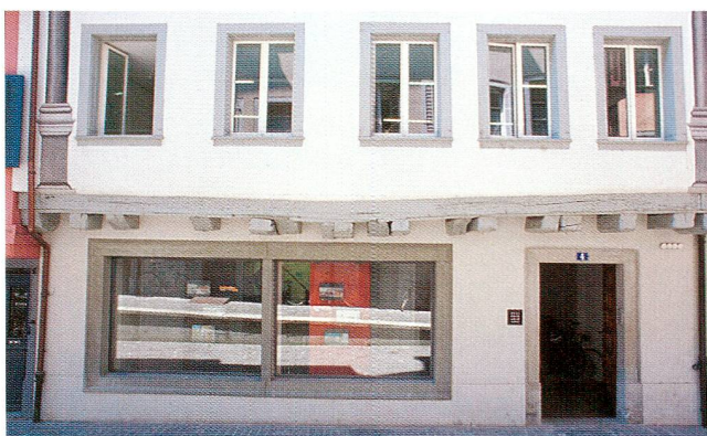
Abb. 41 Zug, Oberaltstadt 4. Ostfassade, Blick nach Südwesten. Jeder zweite vorkragende Deckenbalken des Erdgeschosses, die Bodenbretter und die Schwelle des ersten Obergeschosses gehören zu einem 1371 erbauten Bohlen-Ständer-Bau. Die anderen Deckenbalken des Erdgeschosses wurden 1668/69 gefällt.
