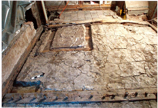
Abb. 49 Zug, St.-Oswalds-Gasse 10. Erstes Obergeschoss, Südwestecke des südöstlichen Raumes. Lehm Mörtelstrich mit dem Negativ des Fundaments eines Kachelofens. Blick nach Westen.
