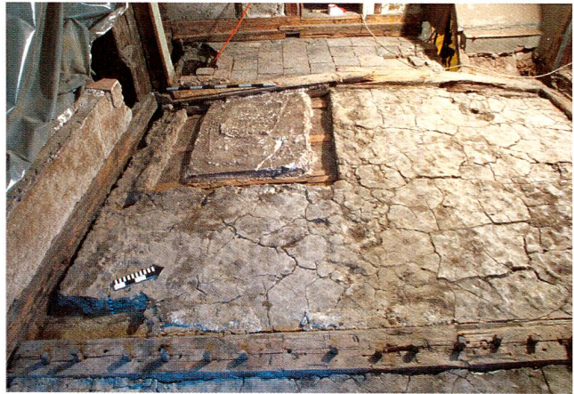
Abb. 49 Zug, St.-Oswalds-Gasse 10. Erstes Obergeschoss, Südwestecke des südöstlichen Raumes. Lehm Mörtelstrich mit dem Negativ des Fundaments eines Kachelofens. Blick nach Westen.
