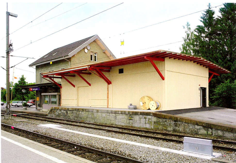
Abb. 18 Steinhausen, Bahnhofgebäude. Erweiterung Lagerschuppen. Ansicht von Süden.
