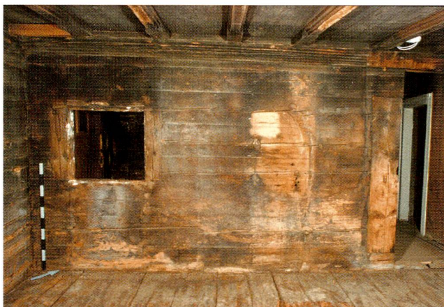
Abb. 23 Unterägeri, Unterblacki. Westwand der Stube mit Bohlen-Bälkchen-Decke, Wandschrank («Pestfenster») links und Stubentüre mit Mantelstud rechts. Unten der ursprüngliche Bretterboden.
