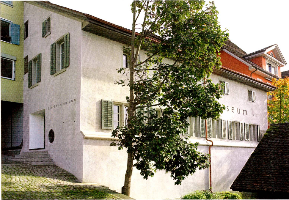
Abb. 53 Zug, Unteraltstadt 14, Fischereimuseum. Ansicht von Nordwesten.
