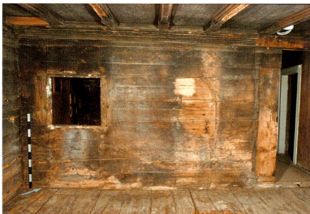
Abb. 23 Unterägeri, Unterblacki. Westwand der Stube mit Bohlen-Bälkchen-Decke, Wandschrank («Pestfenster») links und Stubentüre mit Mantelstud rechts. Unten der ursprüngliche Bretterboden.
