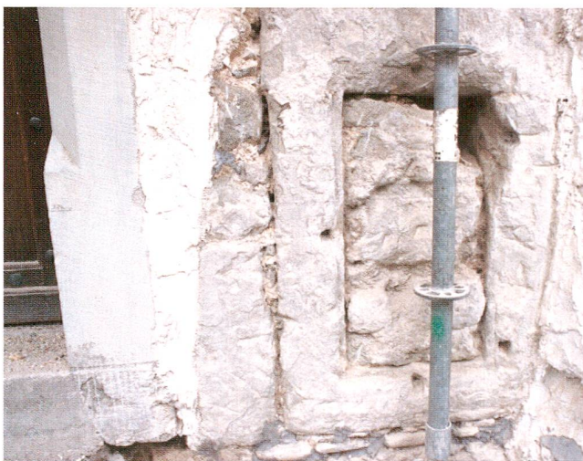
Abb. 21 Unterägeri, Alte Landstrasse 100, Kirche St. Maria, Kirchturm. In der Südfassade befinden sich neben der Türe die Reste eines Sakramentshäuschens, das sich im Chor der spätgotischen Kapelle befand.
