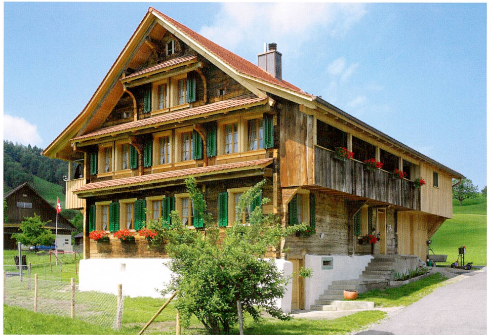
Abb. 22 Unterägeri, Unterblacki. Ansicht von Nordosten.
