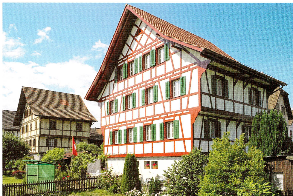
Abb. 7 Cham, Gartenstrasse 14 und 16, Doppelwohnhaus. Ansicht von Süden.
