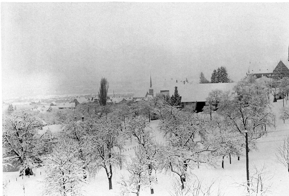
Abb. 35 Anonym, Winterliche Sicht über Zug von Süden, 1902. Diese Aufnahme, die vermutlich von Josef Maria Weber-Strebel stammt, entstand unmittelbar vor dem Ende der Bauarbeiten der neuen Pfarrkirche St. Michael, möglicherweise aber schon nach der Einweihung im Oktober 1902. Am südlichen Querschiff stehen noch letzte Gerüststangen.
