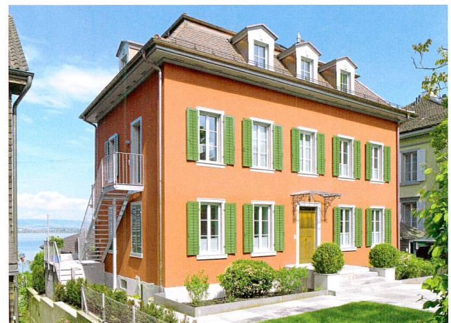
Abb. 45 Zug, Artherstrasse 14a, Wohnhaus. Ansicht von Osten.
