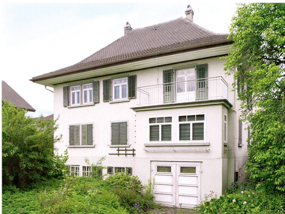
Abb. 15 Cham, Alpenstrasse 5, Wohnhaus. Ansicht von Südosten.
