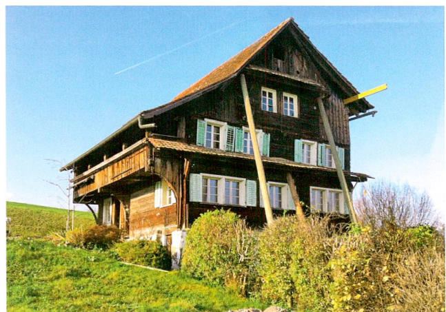
Abb. 36 Risch, Stockeri 9, Wohnhaus. Der 1556/57 errichtete Blockbau wurde im Winter 2011/12 tief greifend umgebaut und dabei bauhistorisch untersucht. Das Dach wurde nachträglich, vermutlich 1792, aufgesetzt. Blick nach Westen.
