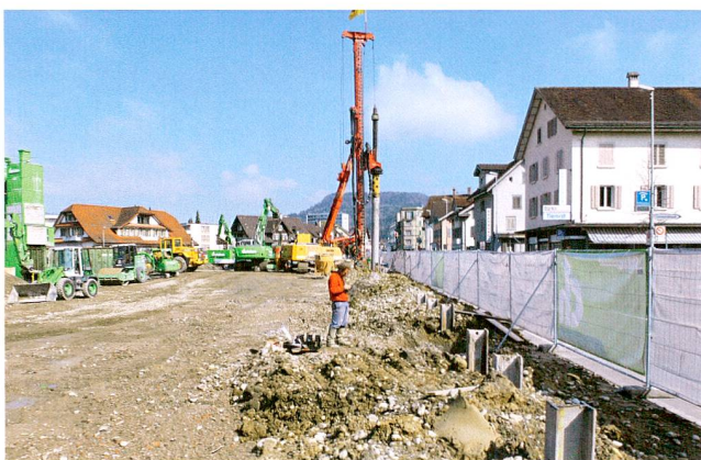
Abb. 10 Baar, Marktgasse/Falkenweg. Nach dem Abbruch der Häuser wurden die Aushubarbeiten archäologisch begleitet. Dokumentation des Sodbrunnens im Trottoirbereich vor dem ehemaligen Haus Marktgasse 7/9. Blick nach Osten.
