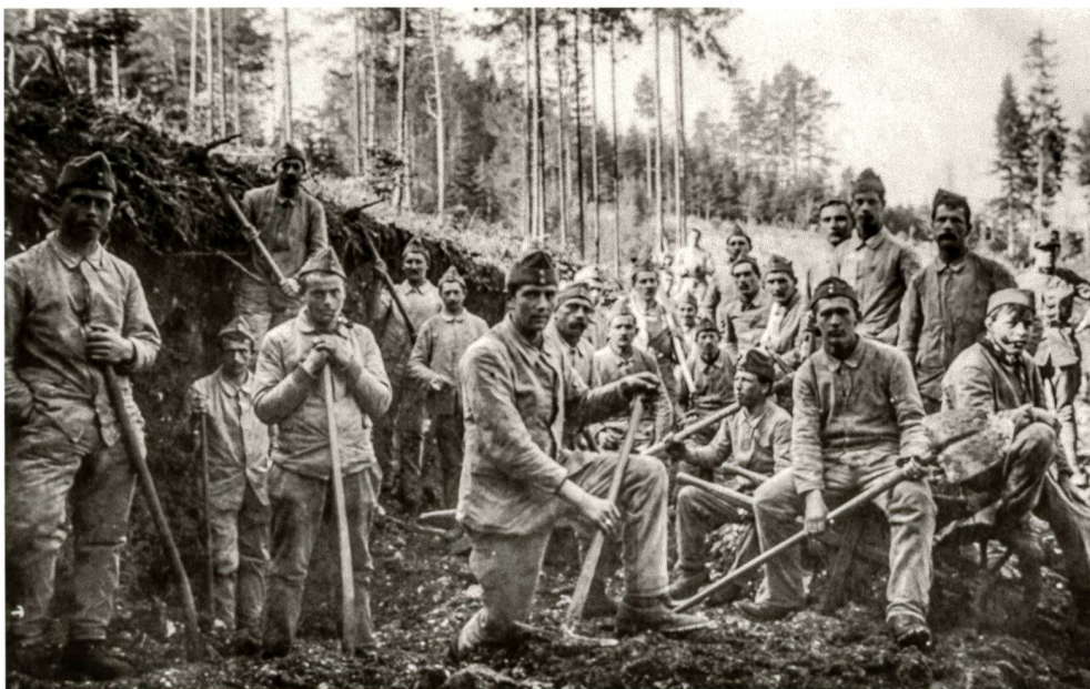
Abb. 6 Soldaten der Zuger Füsilierskompanie II/48 beim Bau der Strasse zur Artilleriestellung Kappelborn am Hauenstein, 17. März 1917.
