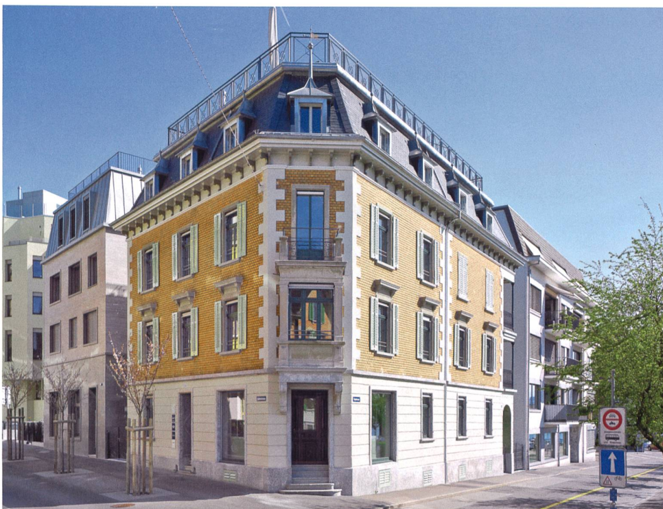
Abb. 33 Zug, Gartenstrasse 7/ Rigistrasse 6, Wohn- und Geschäftshaus. Ansicht von Nordwesten, nach der Sanierung.
