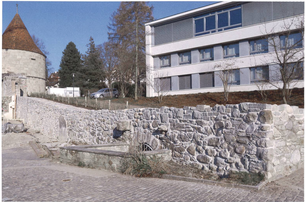
Abb. 32 Zug, Dorfstrasse 29. Stadtseitige Ansicht des gesicherten Rests der Stadtmauer. Links der Huwilerturm. Blick nach Nordosten.
