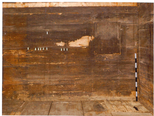
Abb. 16 Oberägeri, Ammannweg 1. Stubenwand mit verschlossener Binnenfensteröffnung. Die Fundorte der menschlichen Zähne und weiterer Objekte in den Schwundrissen sind gelb markiert.
