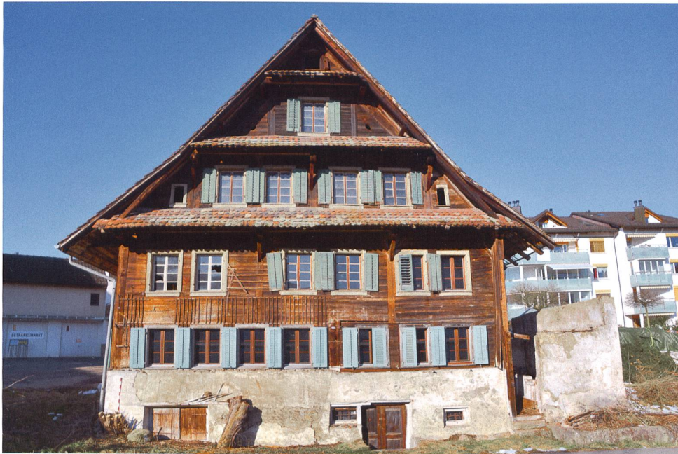
Abb. 15 Neuheim, Lindenweg 2, «Zehnderhof». Ansicht von Südosten.
