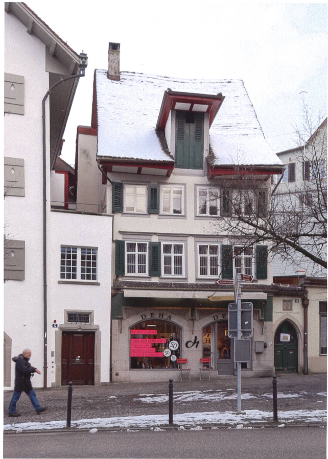
Abb. 35 Zug, Kolinplatz 19. Gassenfassade. Blick nach Osten.
