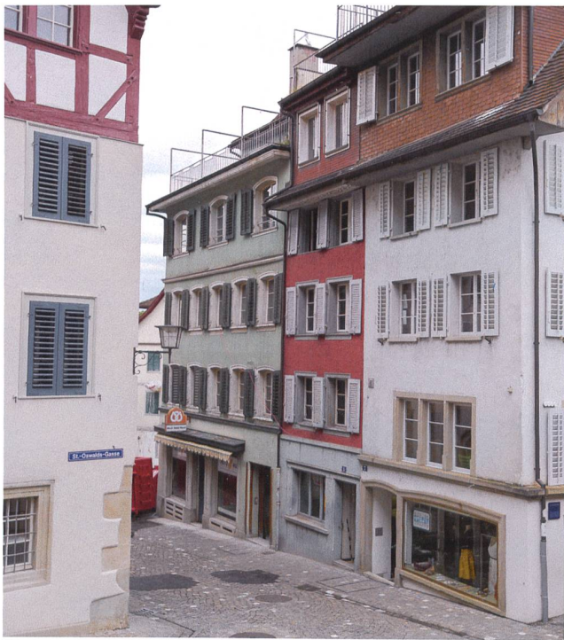
Abb. 1 Zug, Kirchenstrasse 3/5/7. Zustand vor der Sanierung 2016. Blick nach Norden.
