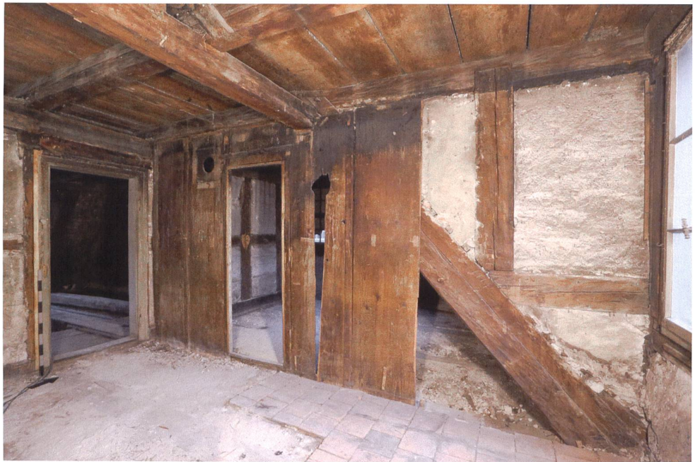
Abb. 36 Zug, Kolinplatz 19. Dachgeschoss. Mittleres Joch des liegenden Dachstuhls mit zur Dachlukarne verlängertem Kehlbalken. Blick nach Norden.
