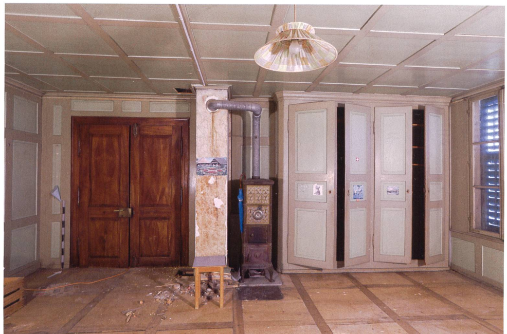
Abb. 11 Hünenberg, Huobweid, Kemberghof. Historische Raumausstattung im zweiten Geschoss. Blick nach Norden.
