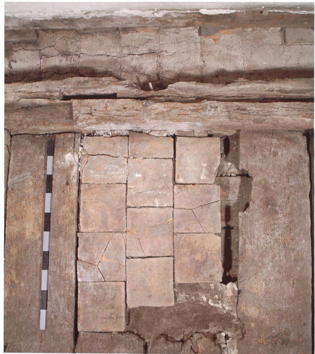
Abb. 7 Zug, Unteraltstadt 26, erstes Obergeschoss, Boden von 1462d, Aufsicht. Fundament eines Kachelofens. Blick nach Westen.
