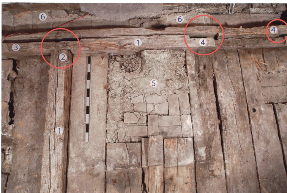
Abb. 6 Zug, Unteraltstadt 26, erstes Obergeschoss, Boden von 1462d, Aufsicht. 1 Schwellbalken. 2 Schwellenschloss und Fundort des Steinfüsschens. 3 Nut für Bohlenwand. 4 Zapflöcher für Türpfosten. 5 Fundament eines Kachelofens. 6 Negative eines Tonplattenbodens im ehemaligen Nebenraum (Küche). Blick nach Westen.
