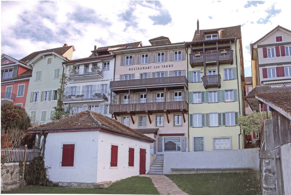
Abb. 9 Zug, Unteraltstadt 26. Westfassade, vor dem Umbau 2016–2018.
