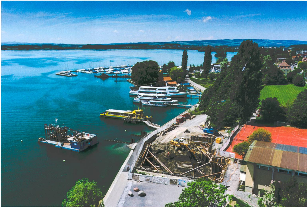
Abb. 44 Zug, Schützenmatt. Gespundete und massiv verspriesste Baugrube, Blick von Osten. Der Bagger steht auf der 2018 ausgehobenen und temporär wiederverfüllten Baugrube des Zielschachts, die Baggermatratzen aus Baumstämmen liegen in der Baugrube der Seewasserzentrale. Im See, vor der Quaimauer, die Spundwand des Seeauslasses, rechts unten die Turnhalle Schützenmatt.
