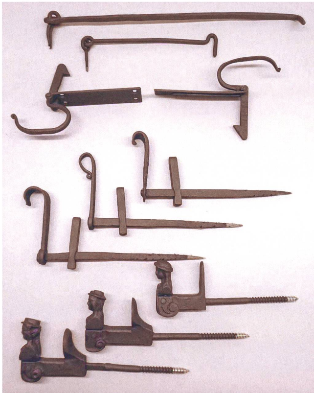
Abb. 11 Kloster Maria Opferung. Unterschiedliche Rückhalter und Beschlagteile der Fensterläden.
