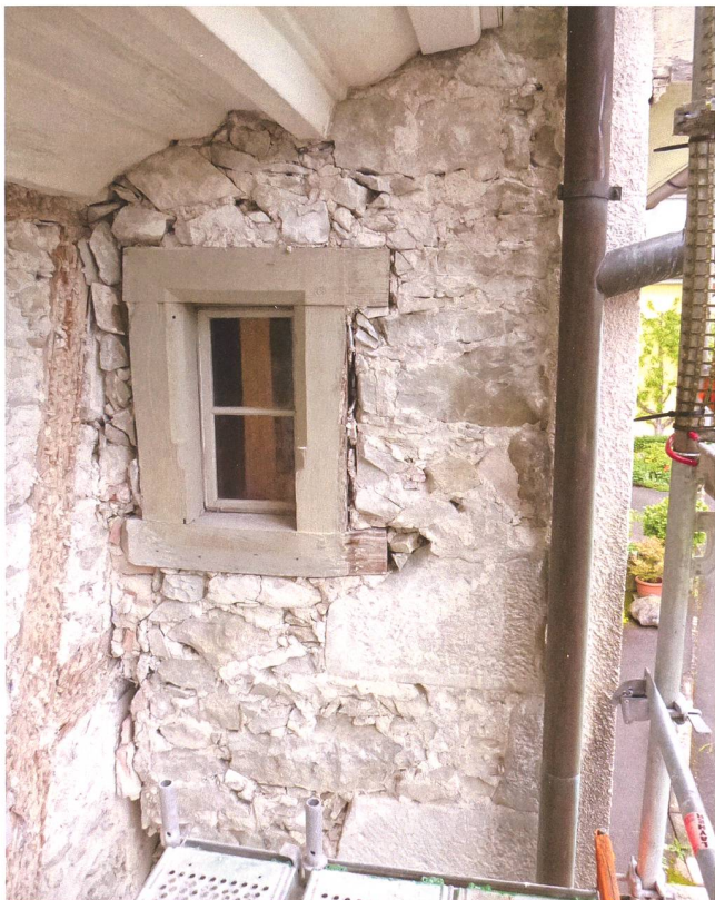
Abb. 6 Kloster Maria Opferung, Südfassade des Konventsgebäudes. Baunaht mit Werkstück und gotischem Fenstergewände.
