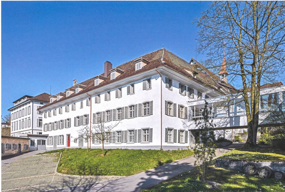
Abb. 14 Kloster Maria Opferung. Ansicht von Südwesten. Nach der Sanierung, 2020.
