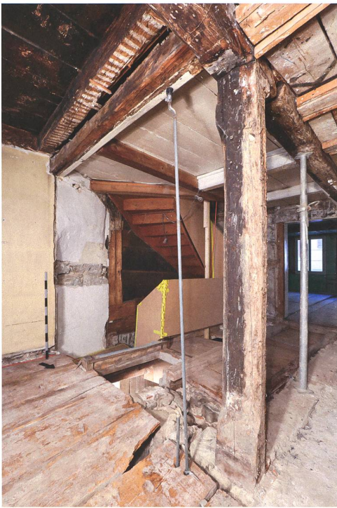
Abb. 3 Deckenbretter und Reste des rückwärtigen Steinbaus von 1448. Unterzug und Stütze von 1709 als Ersatz der gemauerten Wand. Blick nach Westen.
