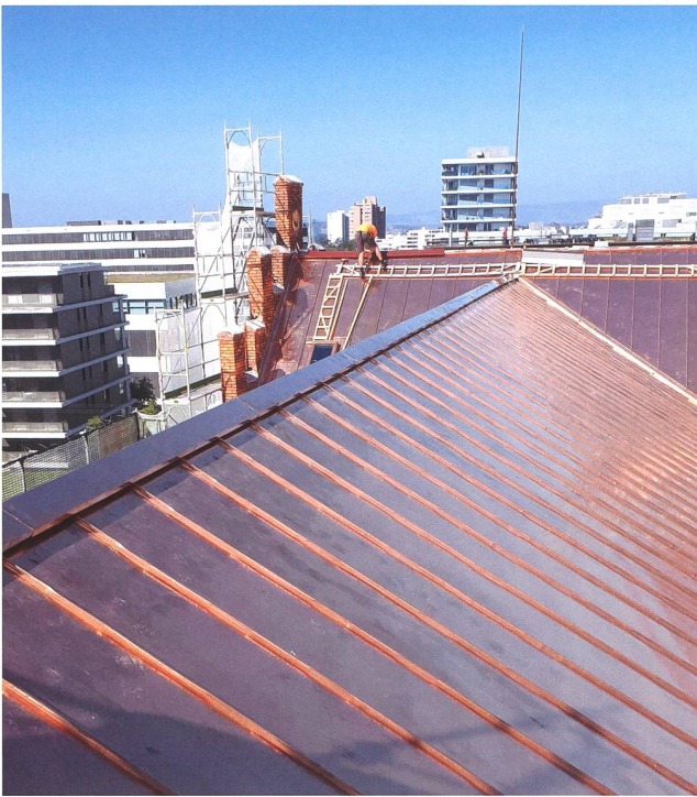
Abb. 3 Neu erstelltes Kupferdach, Blick Richtung Westen.
