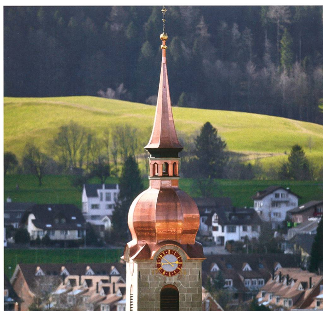
Abb. 15 Unterägeri, Marienkirche. Turm, nach der Sanierung von 2020.
