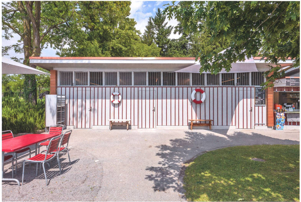
Abb. 9 Cham, Seebad Hirsgarten, Badehaus, nach dem Umbau. Ansicht von Südwesten.
