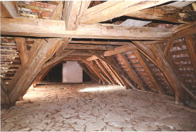
Abb. 3 1495 dendrodatierter Dachstuhl über dem Nordwestflügel. Blick nach Westen.
