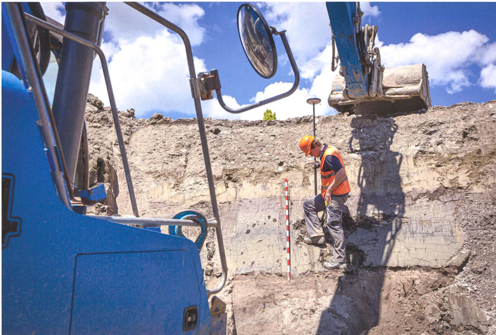
Abb. 20 Zug, Chollerstrasse 26. Vermessungsarbeiten am Stichprofil 3 im Nordosten des Bauperimeters. Unten sind die späteiszeitlichen Deltasande der Lorze zu erkennen, auf Höhe der Jalonspitze zeigt sich ein Erosionshorizont, der hier die frühbronzezeitliche Verlandungsschicht ausgeräumt hat. Gegen oben folgen die unterschiedlich gefärbten, teils organisch angereicherten Auelehme und schliesslich der Schotter des Baustellenplanums.
