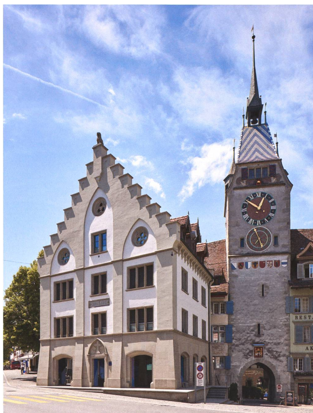
Abb. 27 Zug, Kolinplatz 14, Zollhaus. Zustand nach der Fassadensanierung. Ansicht von Osten.
