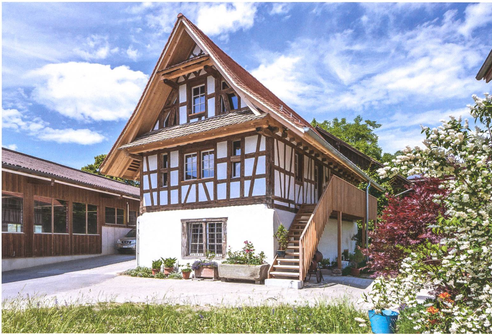
Abb. 7 Baar, Zimbel, Wasch- und Brennhaus. Das sanierte und umgenutzte ehemalige Wasch- und Brennhaus Zimbel, Ansicht von Südosten.
