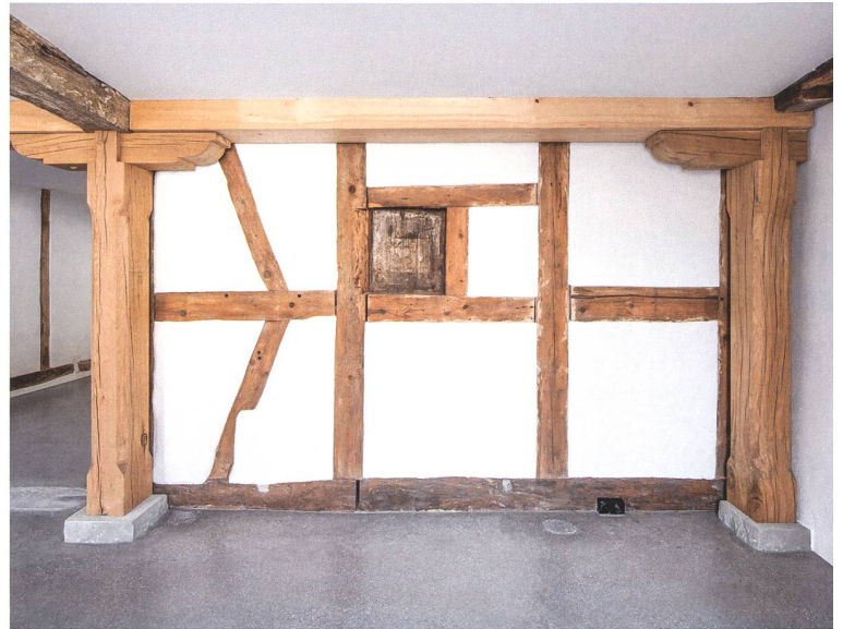
Abb. 4 Erdgeschoss. Fachwerkwand mit neuen Stützen und Unterzug nach der Sanierung 2020.
