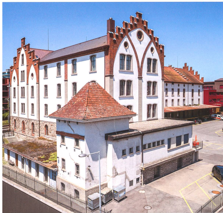
Abb. 1 Zug, Unter müli 1. Ansicht des neu renovierten Gebäudes 1 von Südosten mit wieder deutlich sichtbaren (Eck-)Lisenen.
