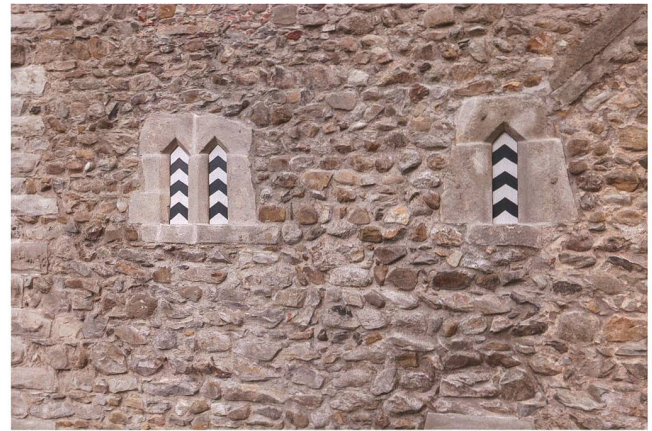
Abb. 2 Mauerabschnitt an der Südwestfassade mit bauzeitlichen Fensteröffnungen und Buckelquader-Eckverband. Blick nach Norden.
