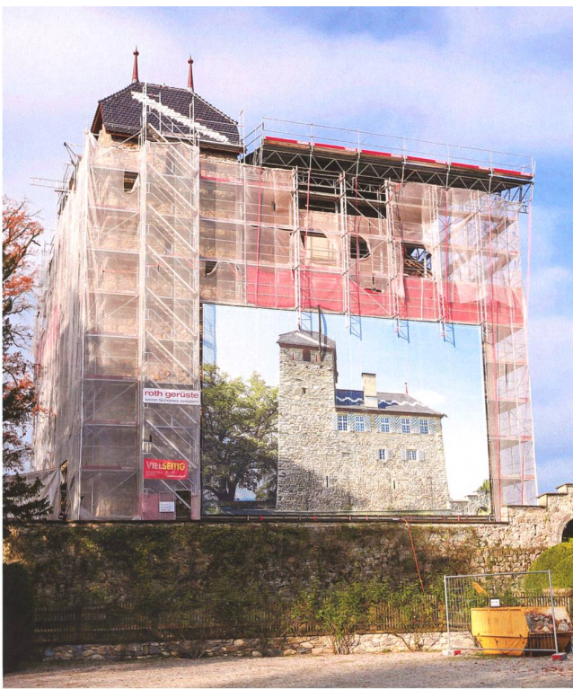
Abb. 1 Risch, Buonas, Schloss Buonas. Ansicht des eingerüsteten Schlosses von Süden.
