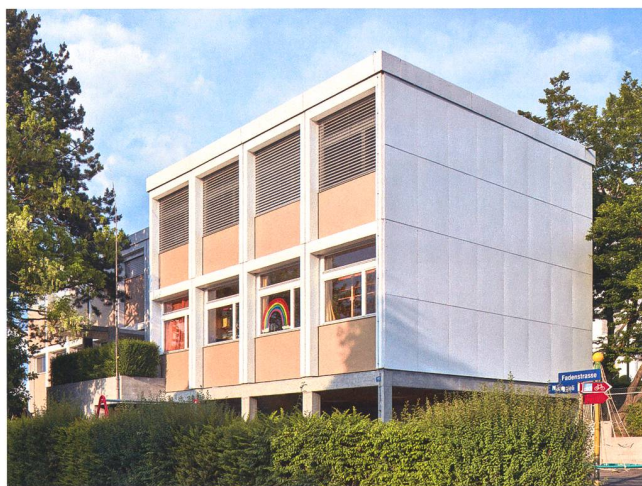
Abb. 23 Zug, Fadenstrasse 15, Schulhaus Hänggeli. Zustand nach der Fassadensanierung. Ansicht von Westen.
