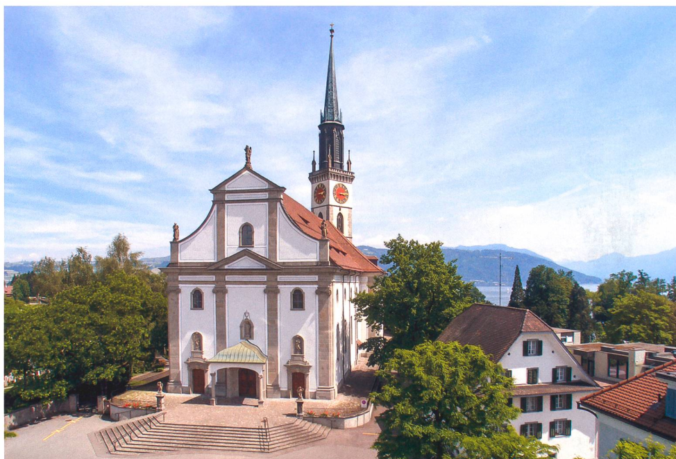
Abb. 1 Während langer Zeit war der spätgotische Glockenturm mit dem neugotischen Turmaufsatz von 1868 der katholischen Pfarrkirche St. Jakob in Cham mit 71,90 m Höhe das höchste Gebäude im Kanton Zug (Aufnahme 2006).
