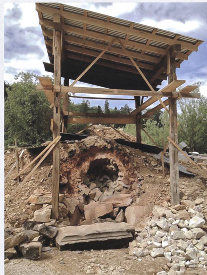
Bau und Betrieb eines experimentellen Kalkmeilers im Steinbruch Gebrüder Thomann in Liesberg (BL). 1 Errichtung von Feuerkammer und Gewölbe. 2 Auftürmen der zu brennenden Kalkladung. 3 Konstruktion des Ofenmantels mit Stroh, Lehm und Holzbrettern. 4 Betriebsbereiter Kalkmeiler mit Schutzdach. 5 Einheizen der Feuerkammer. 6 Durchgeglühter Kalkstein aus der Kalkkammer. 7 Eingestürztes Gewölbe. 8 Abbruch des Ofenmantels. 9 Prüfung der gebrannten Kalksteine.
