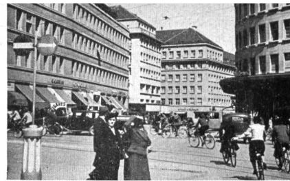
Le quartier moderne de la « City » construit sur l'emplacement d'anciennes propriétés patriciennes. On y trouve encore beaucoup de maisons de soieries.
