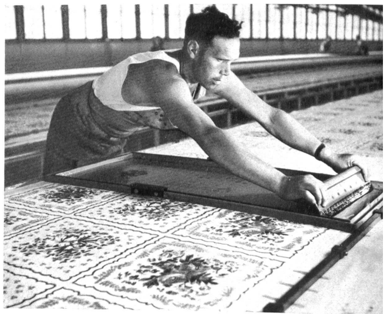
Estampado de pañoletas por el procedimiento con estarcido.
