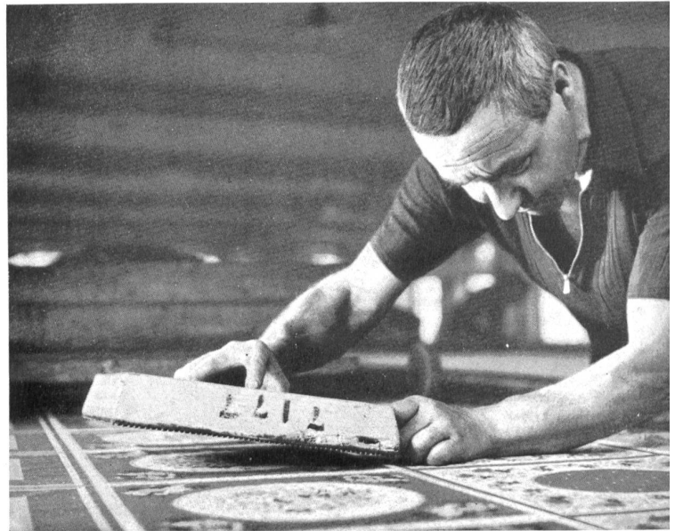
Estampado de pañuelos a mano mediante matrices grabadas en madera
