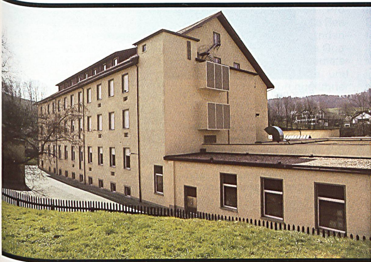
Das Spinnerei-Gebäude in Dietfurt / La filature de Dietfurt / The spinning works at Dietfurt.
