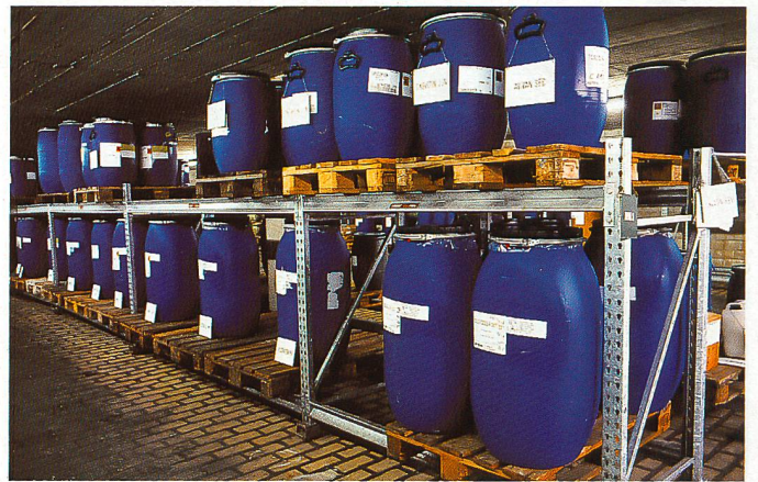
7 Chemikalienlager mit Auffangschächten ohne Ablauf. Cilander, Herisau.
