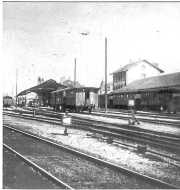
des marchandises puis la marquise du vers 1910 (AEF)
