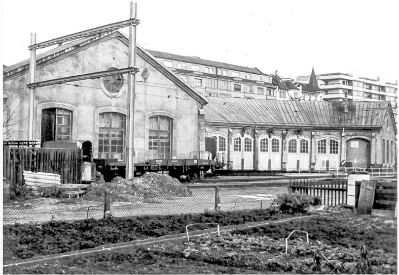
La remise des locomotives de la Compagnie des Chemins de fer de la Suisse Occidentale en 1981, avant sa démolition
