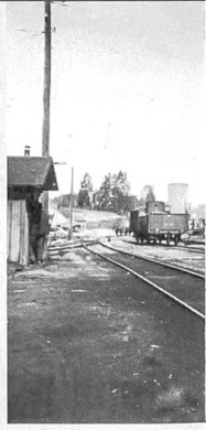
Direction Berne, la gare bâtiment aux voyageurs
