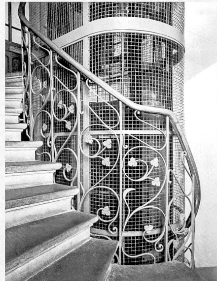
La cage d'escalier avec sa rampe en fer forgé conservée malgré l'installation postérieure d'un ascenseur
