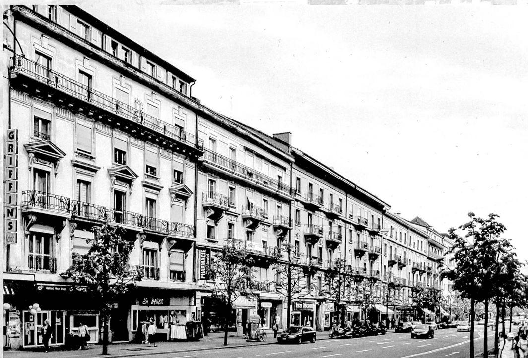
Ensemble de 7 immeubles de rapport construits entre 1898 et 1904 pour la Société anonyme des Pilettes, la Société immobilière Sarinienne et la Société immobilière L'Avenir, sur les plans des architectes genevois Johannès Grosset (1866-1957) et Ami Golay (1866-?)
