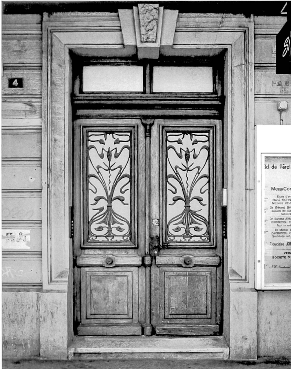
Entrée de l'immeuble n° 4, porte néo-classique et grilles Art Nouveau
