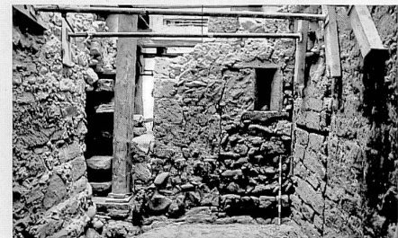
Façade primitive sud de la maison occidentale, l'une des trois qui composent la bâtisse actuelle, fin XII e -XIV e siècle (état visible en 1992)
