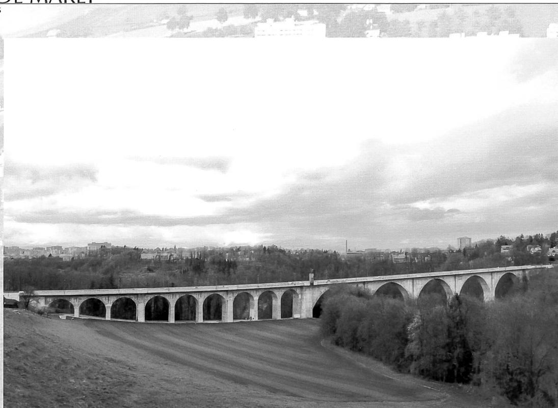
Ouvrage en béton réalisé en 1920-1922 par l'entreprise Züblin & Cie de Zurich et le charpentier grison Richard Coray, d'après les plans et sous la direction des ingénieurs Jules Jaeger et Armin Lusser, de Fribourg, tablier refait et élargi en 1995-1997
