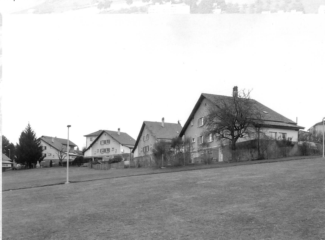
Habitat groupé de 6 maisons familiales jumelées, construites en 1945-1946 par la Société coopérative immobilière «La Solidarité», sur les plans de l'architecte Louis Vaucher
