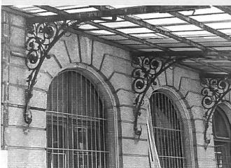
Détail de la marquise disparue en 1976
