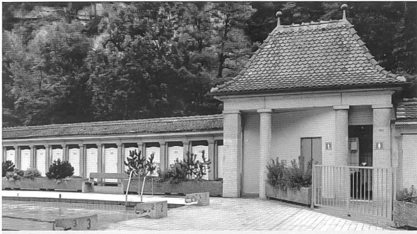
Pavillon de WC et cabines, état en 1999 (P. Bosshard, RAC)
