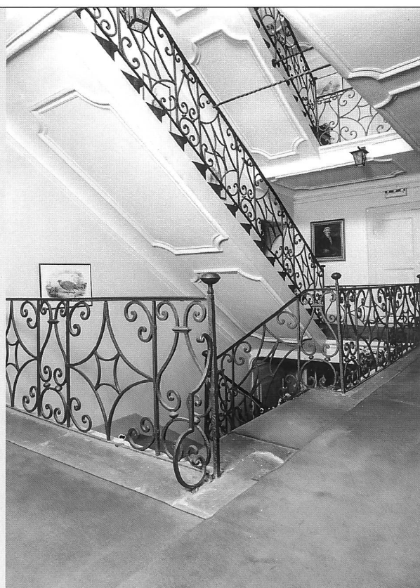
La cage d'escalier réalisée vers 1734-1735, avec rampes en fer forgé attribuables à Joseph Soller
