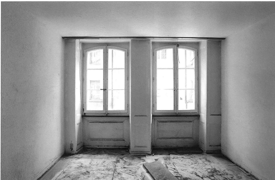
Rue de la Neuveville 17, le salon du 1 er étage en cours de travaux, 1769-1770
