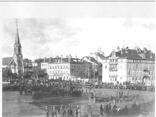
Grandes manœuvres du corps des pompiers de la ville de Fribourg, dans les années 1900 (Centre de secours et d'incendie, Fribourg)
