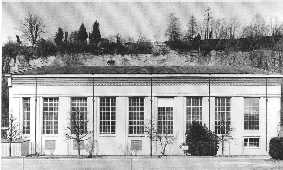
La façade sud de l'usine thermique, état actuel
