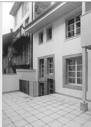
La façade arrière du Gothard, après restauration
