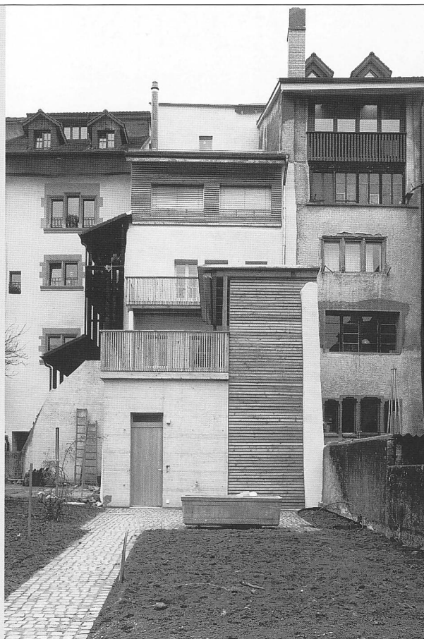
Façade arrière après restauration
