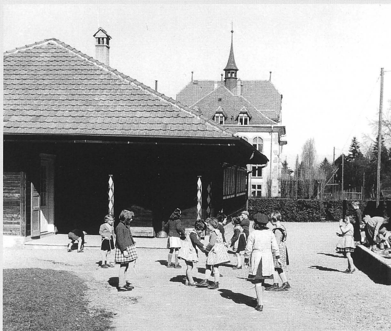
Le pavillon de l'École enfantine, jadis école frœbélienne dirigée par les Ursulines, démonté en 1972 et reconstruit à Avry-devant-Pont (BCUF, Fonds Jacques Thévoz)
