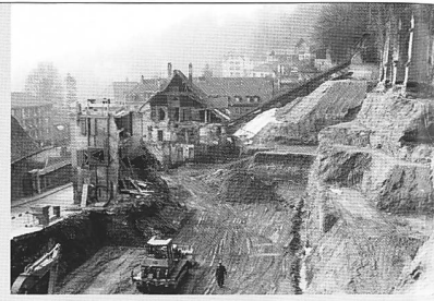
Etat du site le 13 mars 1985, après la démolition des bâtiments et l'excavation des jardins en terrass
