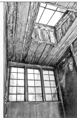
Le puit de lumière de 1736-1740, état en 1989
