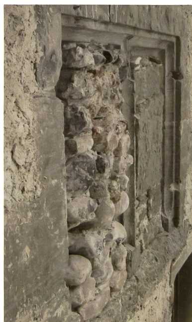
BAIE JUMELÉE À DOUBLE CAVET, 3 e QUART DU XVI e S.
