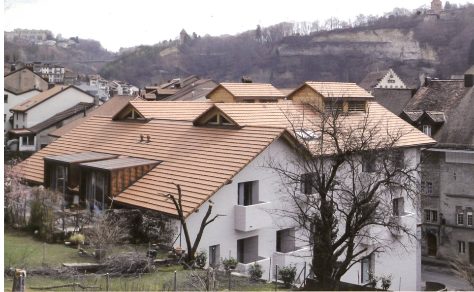
LE BÂTIMENT ACTUEL CÔTÉ JARDIN AVEC LA GLACIÈRE RÉHABILITÉE EN LOGEMENTS ET LES TOITURES À LANTERNAUX DES ANCIENS SÉCHOIRS À PEaux AMÉNAGÉS DANS LA SURÉLEVATION DE 1911
