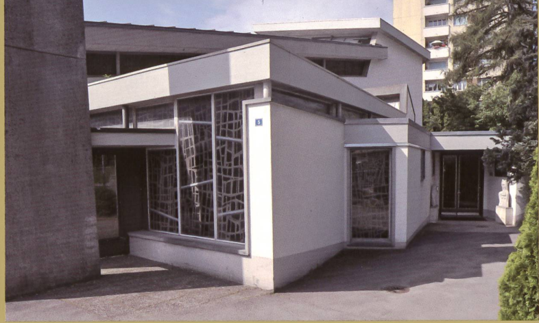
AU-DESSUS DE LA CHAPELLE DE SEMAINE ET DE L'ÉGLISE, LES DÉCROCHEMENTS DE LA DALLE ET LEURS HAUTS JOURS INVISIBLES DEPUIS LES NEFS. TOUT À DROITE, LA CHAPELLE MORTUAIRE ANNEXÉE EN 1976
