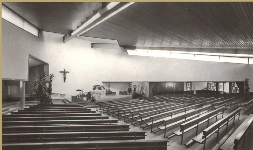
L'INTÉRIEUR DE L'ÉGLISE VERS 1970, AVEC L'ÉCLAIRAGE D'ORIGINE, LUMIÈRE NATURELLE ISSUE DES HAUTS JOURS VITRÉS ET LUMIÈRE ARTIFICIELLE DE LA RAMPE DE NÉONS ACCROCHÉE AUX POUTRES MÉTALLIQUES (BCUF, FONDS CARTES POSTALES)
