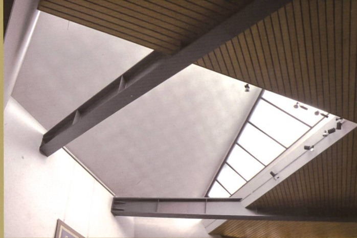
LE Puits de lumière du chœur, par simple décrochement des dalles de couverture, libère les poutres métalliques des deux demi-portiques et met en scène leur liaison sur le mur de chevet
