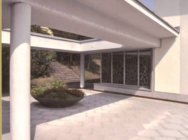
LE PSEUDO-PÉRISTYLE LIANT LE BÂTIMENT PAROISSIAL ET L'ÉGLISE. LE CADRE SERT DE LIAISON ET FORME BRISE-SOLEIL SUR LA CHAPELLE BAPTISMALE, AMORTISSANT LA LUMIÈRE SUR SES DALLES DE VERRE
