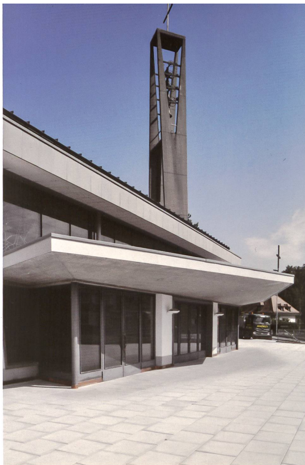
LE PARVIS DE L'ÉGLISE ET SON PORCHE SOUS UN AUVENT EN PORTE-À-FAUX COUPANT LA GRANDE PAROI DE VERRE DE L'ENTRÉE
