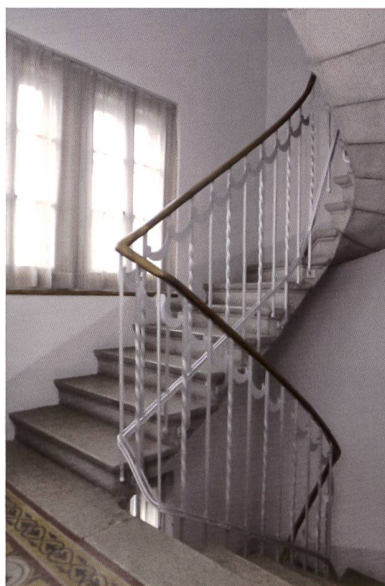
GARDE-CORPS EN MÉTAL DE LA CAGE D'ESCALIER, 1912 (RBCI FRANCESCO RAGUSA)
