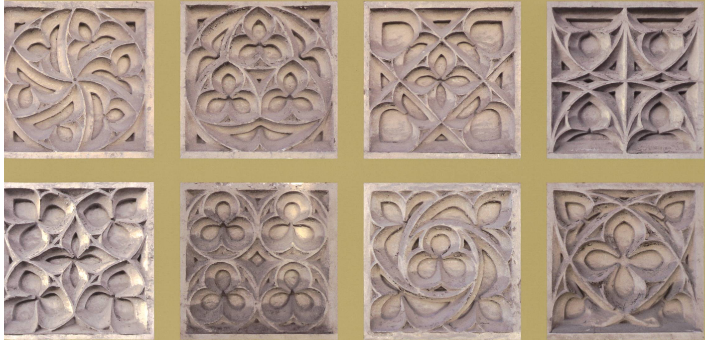
LES REMPLAGES AVEUGLES GOTHIQUE FLAMBOYANT, ENTRE 1404-07, UNE DÉMONSTRATION DE GÉOMÉTRIE ET DE TAILLE DE LA PIERRE
