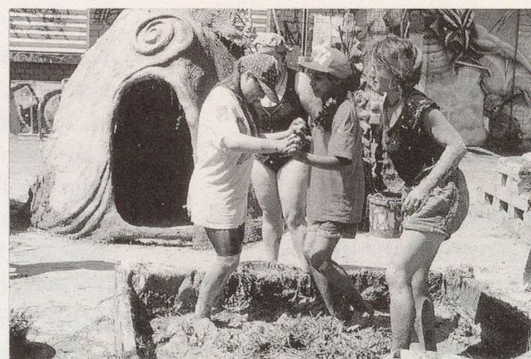
Ein Haus aus dem Boden stampfen: Lehmziegel herstellen, auf deren Basis skurrile Unterkünfte entstehen.
