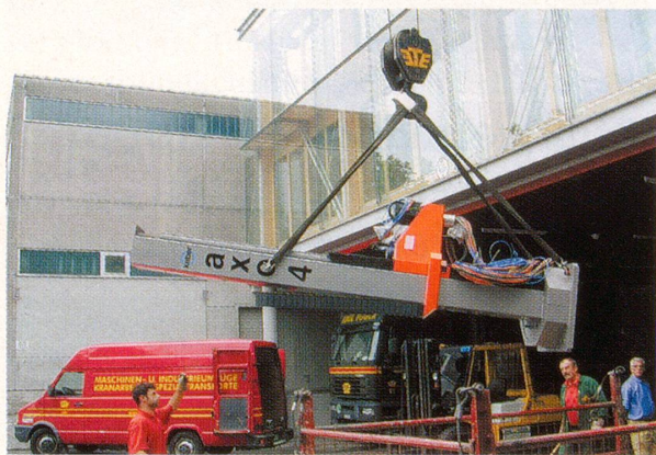
Anlieferung des Roboters mit Hilfe eines grossen Krans.
