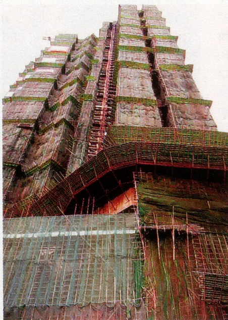
Im Hochbau auch heute noch unverzichtbar: Bambusgerüste.
