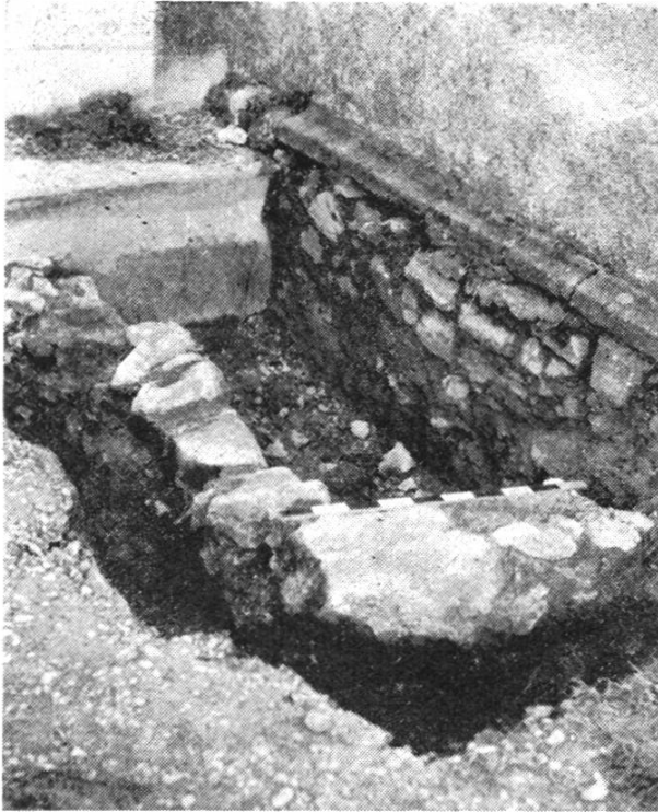
Abb. 4. Altes Mauerwerk nördlich des Turmes.
