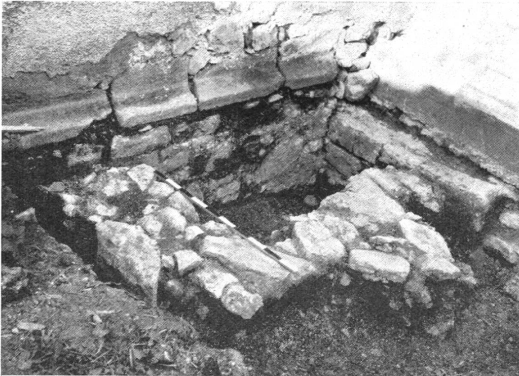
Abb. 3. Altes Mauerwerk südlich des Turmes.
