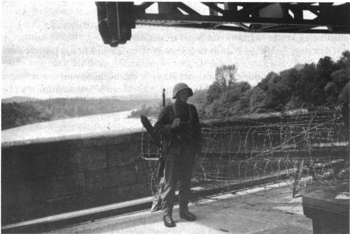
Wacheschieben, Kraftwerk Laufenburg
