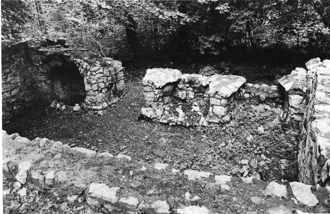
Abb. 4: Ansicht des Röststadels von Süden, heutiger Zustand (Verfasser)
