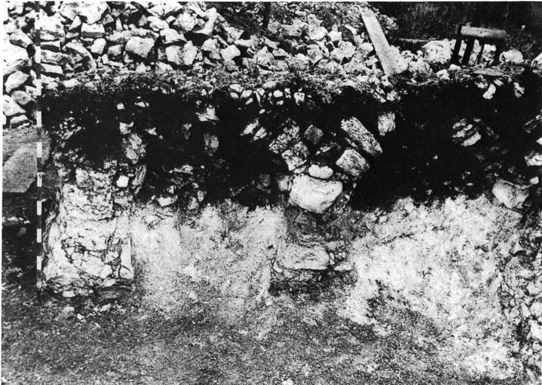
Abb. 6: Zuglöcher Nr. 2 und 1 in der Nordwand, von innen gesehen Befundzustand 1948 (Aargauische Kantonsarchäologie)
